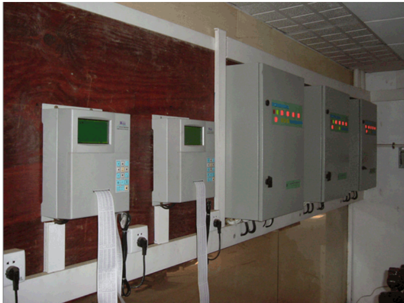
全自动木材干燥控制系统的前端主机及执行箱
